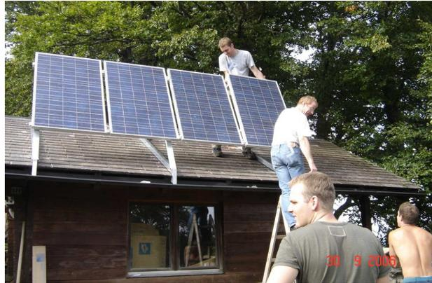
Bild: Montage der Solaranlage auf dem Holzschopf der Skihütte (2006)
